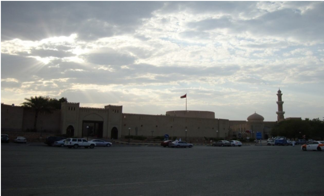
رقم الصورة ٤: صورة تجمع بين قلعة نزوى والسوق والجامع بعد الترميم وإعادة البناء بالنسبة للسوق والجامع.
